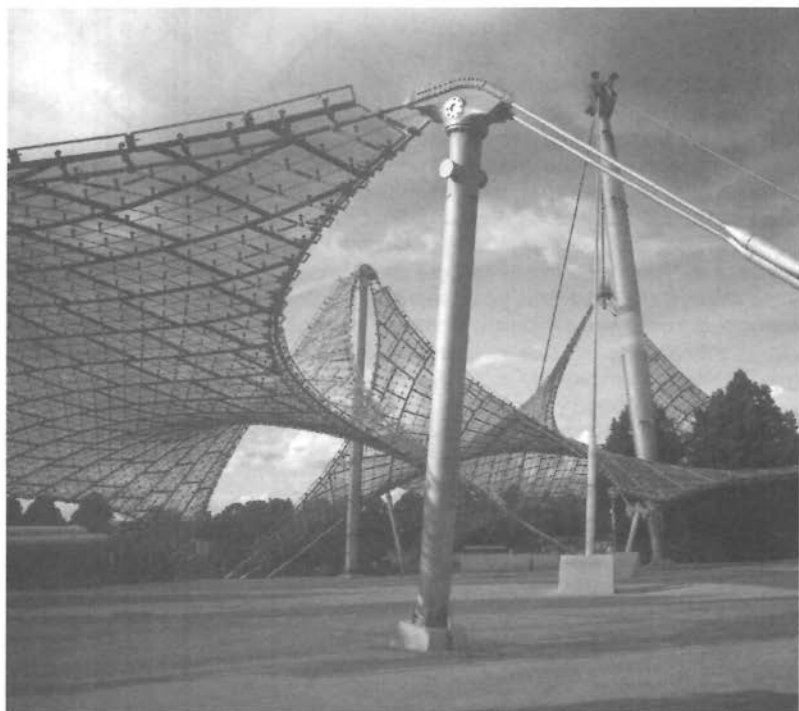
FOTO SUPERIOR: El techo del estadio olímpico de Múnich es una superficie mínima, y para diseñarla se echó mano del cálculo de variaciones.
