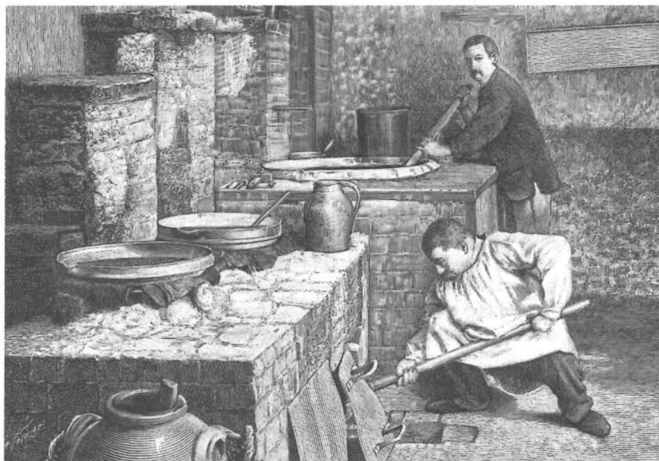
FOTO INFERIOR: Grabado de 1900 que muestra los trabajos realizados en el laboratorio del matrimonio Curie para extraer radio de la pechblenda usando carbonato sódico.
