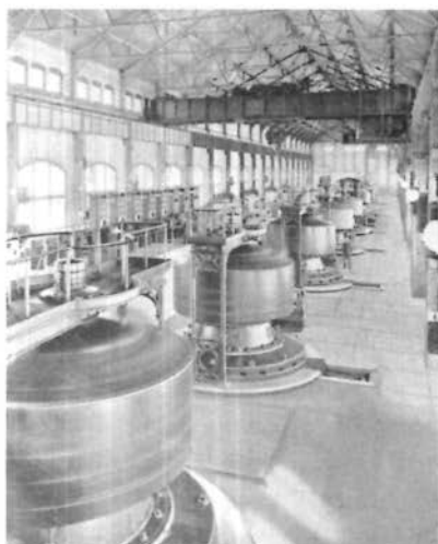
Sala de generadores de la central eléctrica número 1 de la planta hidroeléctrica del Niágara, bautizada como central Edward Dean Adams.
