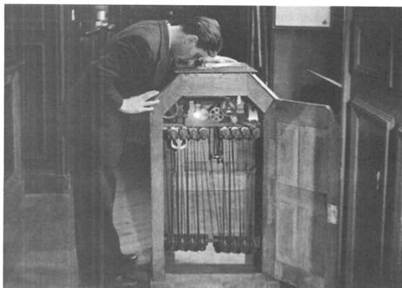
FOTO SUPERIOR: Imagen promocional que muestra el modo de uso y el mecanismo interior del kinetoscopio, el precursor del moderno proyector cinematográfico, que hizo su aparición pública el 9 de mayo de 1893.
