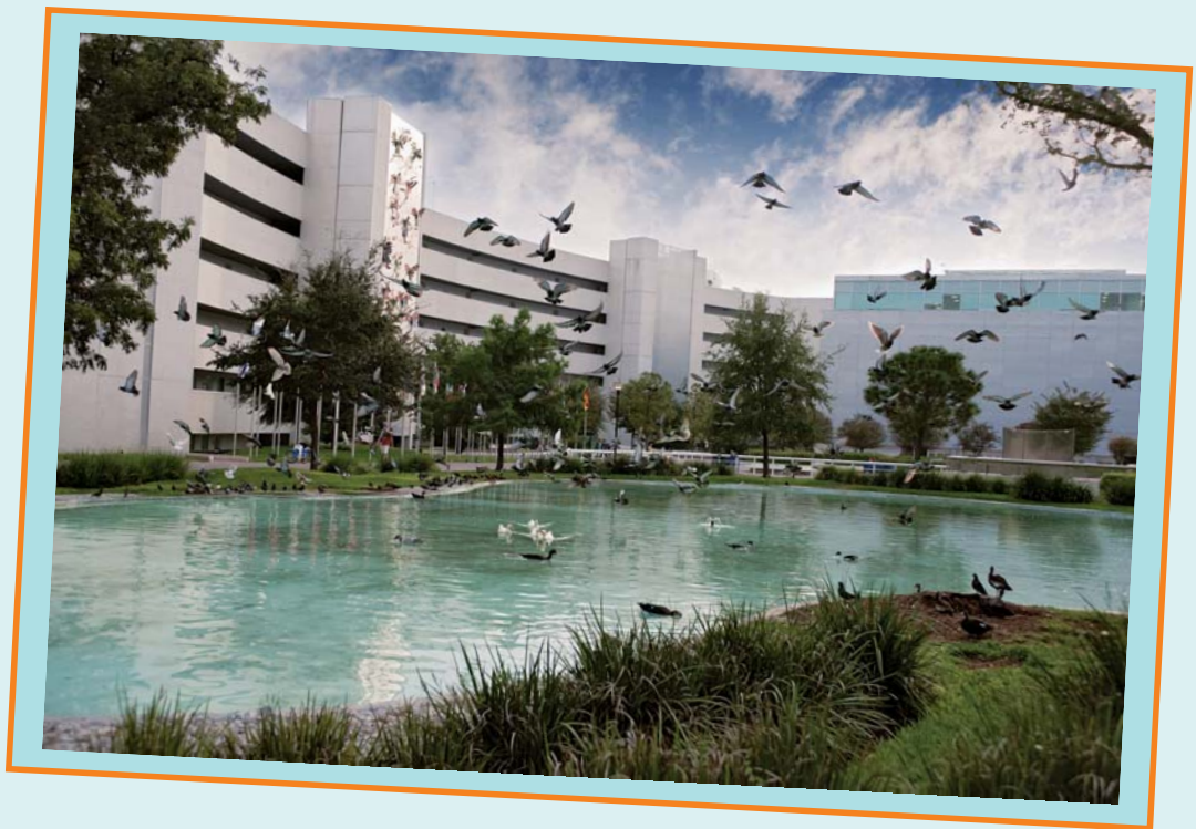
Vista del Lago adjunto al Edificio CIAP.
