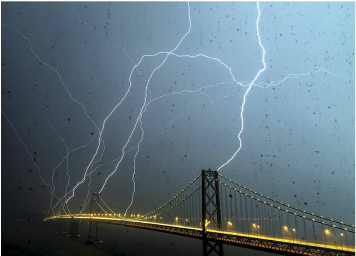
FIGURA II.12. Rayo de tierra a nube, desde la Torre Eiffel (imagen anterior) y desde el puente de San Francisco (arriba).
