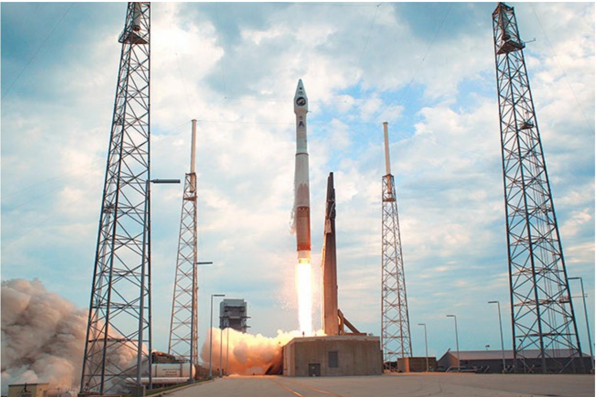
FIGURA III.5. Lanzador espacial Atlas V a punto de despegar en el Centro Espacial Kennedy en misión exploratoria a Plutón (Florida, EUA, enero de 2006), protegido contra los rayos mediante una red de cables conductores conectados a tierra y sostenidos sobre el lanzador por cuatro mástiles aisladores. Imagen: Kennedy Space Center Public Affairs.
