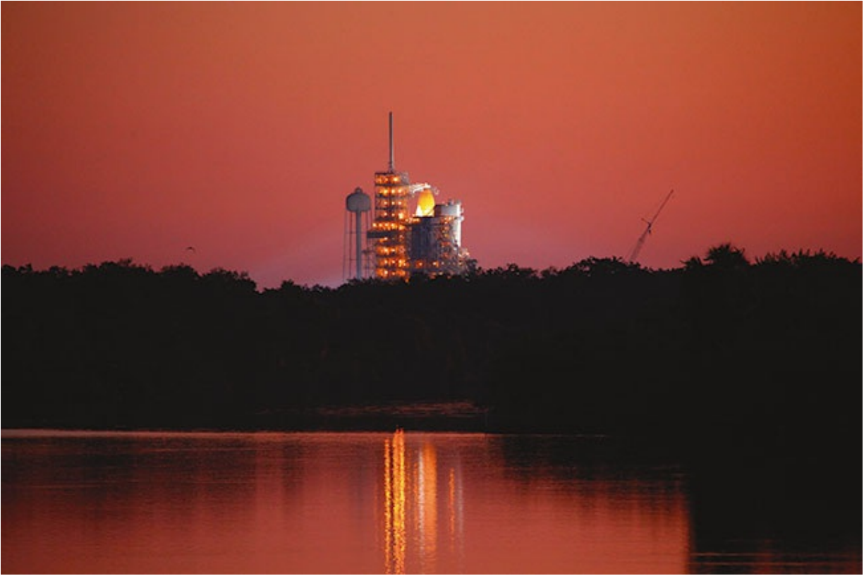
FIGURA III.6. Transbordador espacial en su plataforma de lanzamiento, protegido contra las descargas eléctricas atmosféricas por un hilo de unos m de largo con ambos extremos fijos a tierra, que cuelga por su punto medio de lo más alto de la estructura de apoyo. Imagen: NASA/Frank Michaux.
