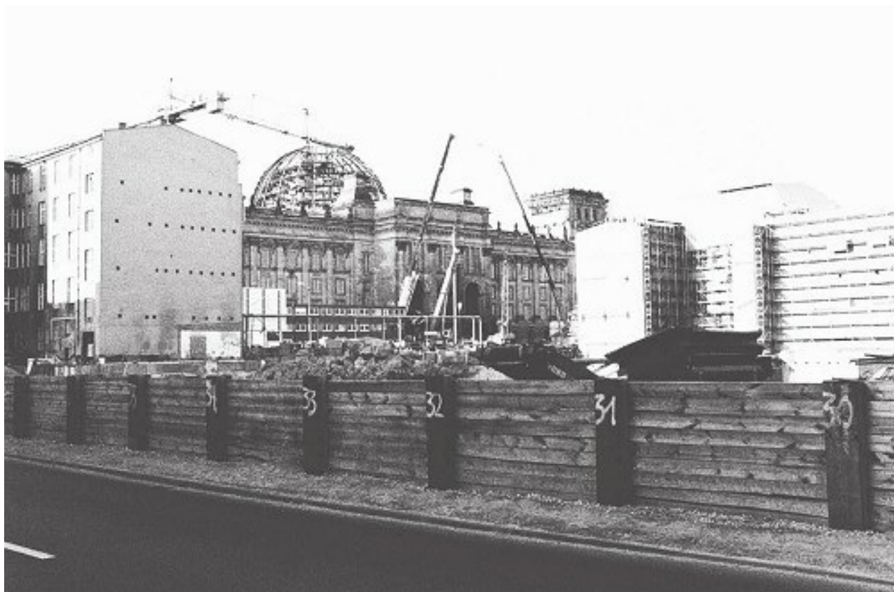
Construcción de la nueva cúpula del Reichstag, 1997
