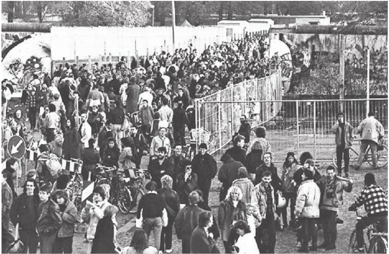
Schlessische Strasse/Puschkinallee, Berlin Occidental, 11 de noviembre de 1989
