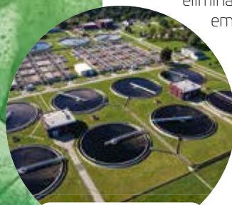
Tratamiento de aguas residuales mediante lodos activos.
